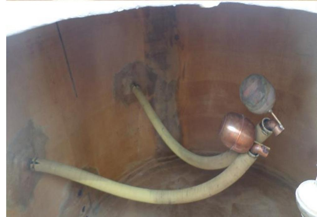
Cambio y calibrar flotadores y mangueras de succión por gravedad y presión. Tanque 1 Torre 1.
