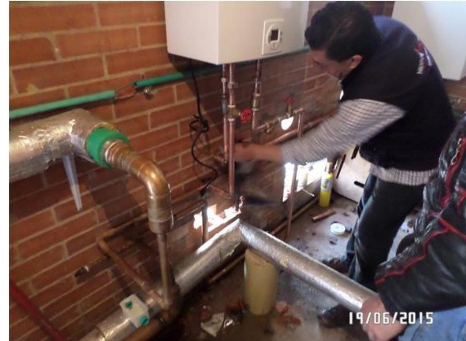
Retiro de las Motobombas de elevación ubicadas en Sótano 3, (Motobomba 2 de torre 1 y Motobomba 1 Torre 3). Por el personal técnico y profesional de Bombas y Riegos ByR.
